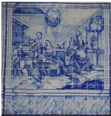
Figura 18 - Após o restauro
