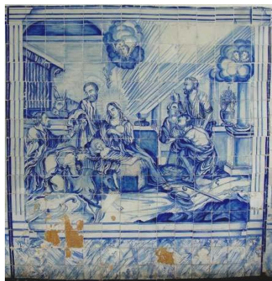
Figura 17 - Antes do restauro
