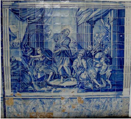
Figura 1 - Jesus expulsa os vendilhões do templo. Painel com 255 peças, sendo que 46,40% estavam danificadas.
