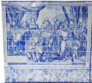
Figura 16 - Após o restauro
