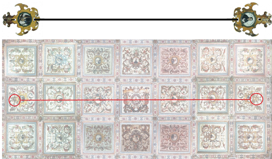
FIGURA 15 – Os tensores do monocórdio e a sua identificação no teto da sacristia. Fotografia e tratamento de imagem de Belinda Neves
