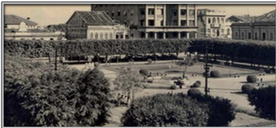
Figura 7 - Praça da Piedade nos anos 30. (A Secretaria de Segurança Pública ao meio tendo, no lado esquerdo o casarão colonial primeira sede da Escola Normal de Música e, ao lado direito o prédio adquirido em 1936, sede própria da Escola Nova de Música até o encerramento das atividades) (acervo da ENM)
